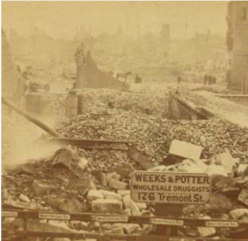
Ruines dans le centre de Boston après l'incendie du 9 novembre 1872. (NYPL)
